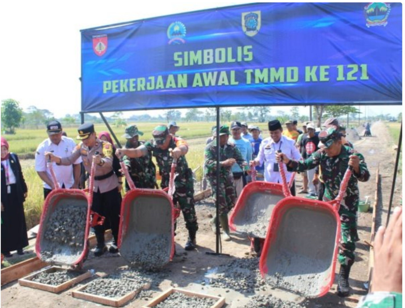
Pengecoran Perdana TMMD Reg 121 dilakukan Forkopimda Klaten
